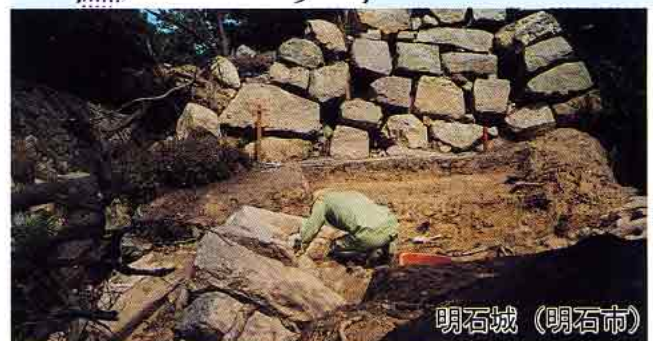
地震で壊れた石垣の調査 明石城 (明石市)
