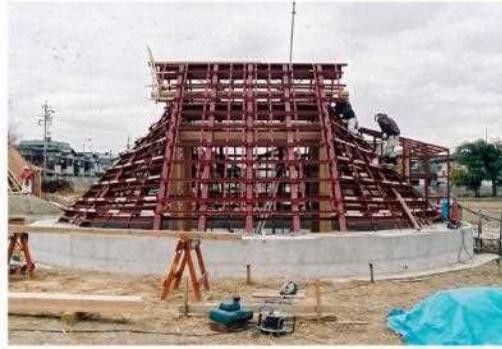
木柱等と鉄骨アングルの設置
