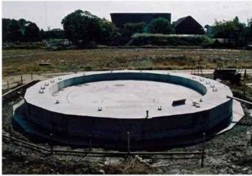
コンクリート基礎の設置
