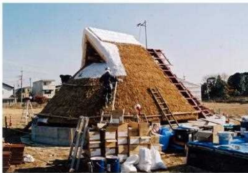
茅葺き後のシリコンによる型取り
