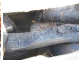
9号住居小火災_3 炭化した木材（修繕時に確認）
