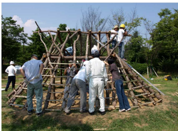
写真1 2202号住居の建築(垂木の取り付け)
