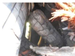
9号住居小火災_3 炭化した木材（修繕時に確認）
