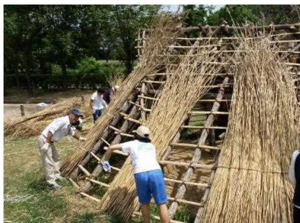
写真2 2202号住居の建築(茅葺き)
