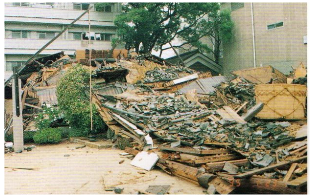
写真1 被災した酒蔵（神戸市）
