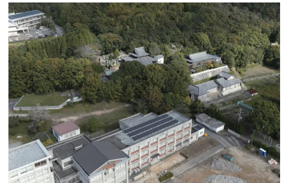
1区と報恩寺（南西から）
